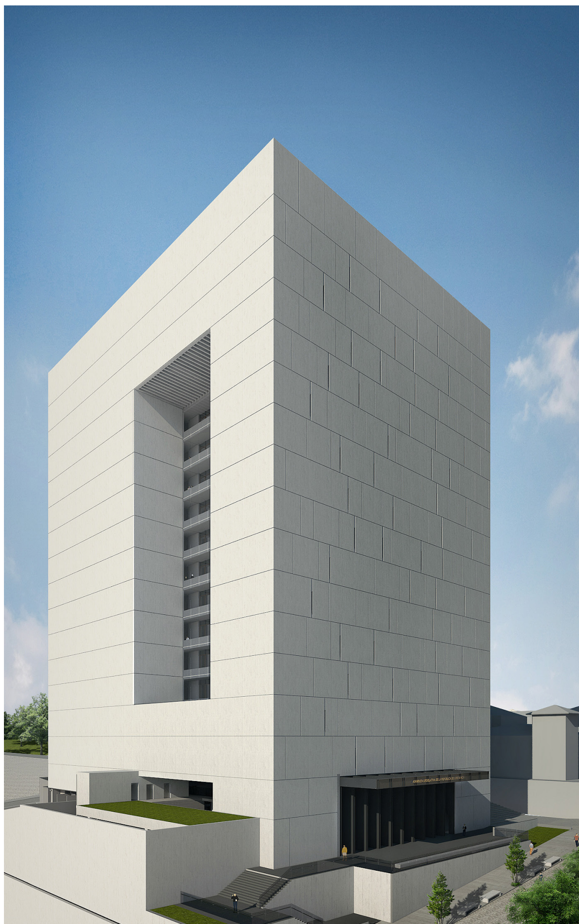
Figura 2. Render Vista SO del segundo diseño para el edificio legislativo. Fuente: Asamblea Legislativa, Documentos de Consultas, Renders, 04 Vista SO. Tomado de: http://www.asamblea.go.cr/ga/Proyectos%20Sede%20Legislativa/2-Proyecto/Renders/04%20Vista%20SO.jpg
