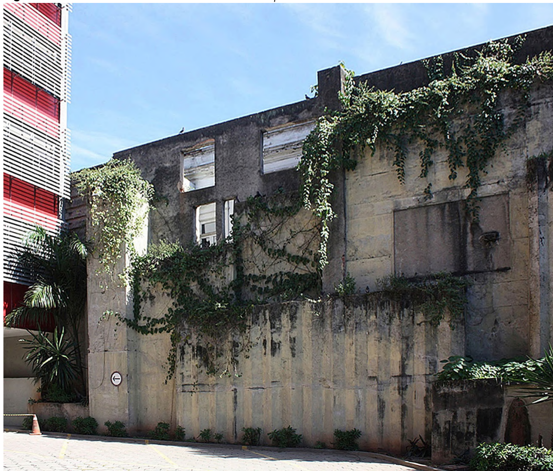
Figura 6. Jardim vertical construído sobre uma das paredes do edifício demolido.
