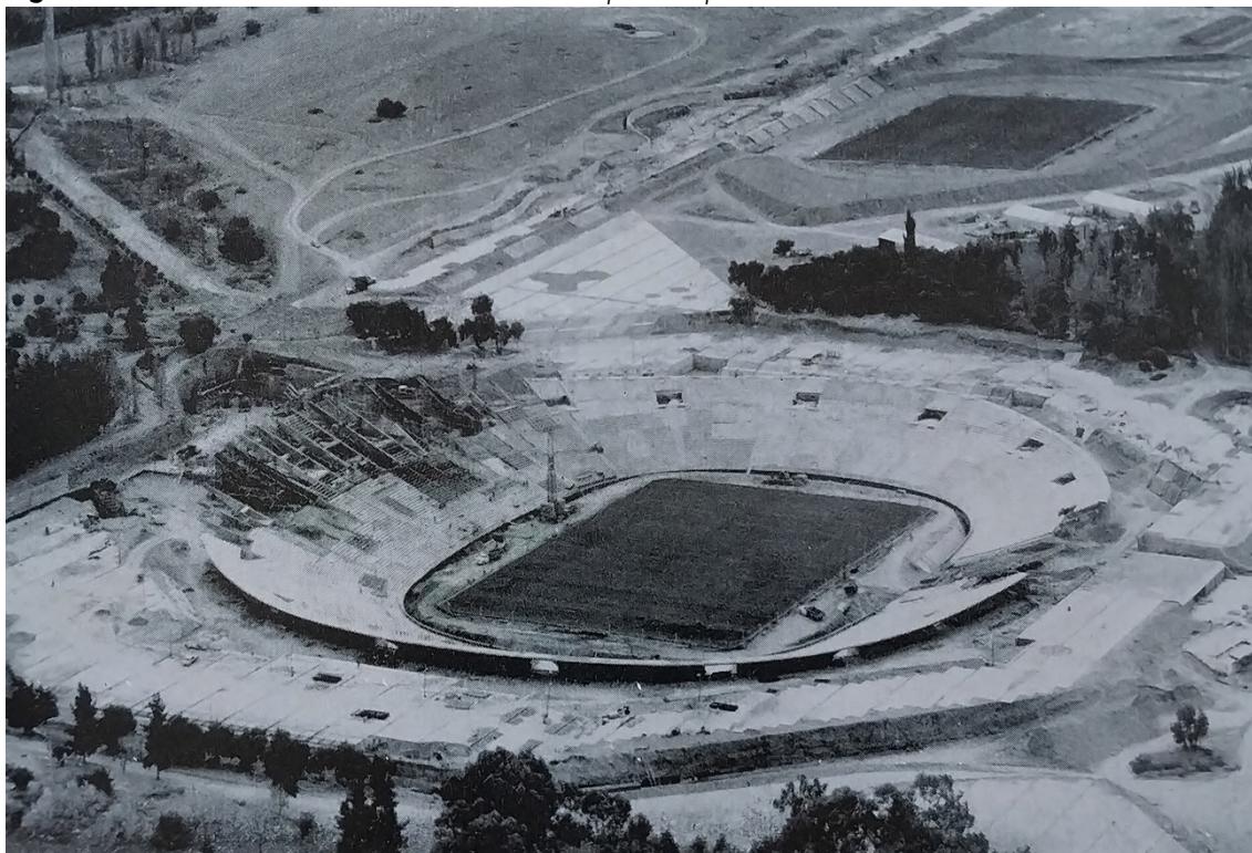
Figura 4. Vista del estadio en construcción donde puede apreciarse el contexto de inserción
