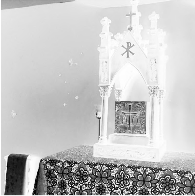
Figura 10. Perforación por proyectiles en las paredes de concreto internas del edificio y en objetos. Imagen editada a negativo blanco y negro
