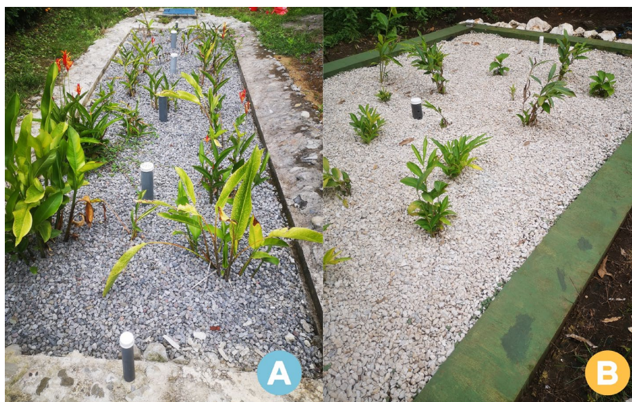
Fig. 9. Ejemplos de sustratos utilizados en humedales artificiales: (a) piedra cuarta y (b) piedra cuarta de tipo caliza.
