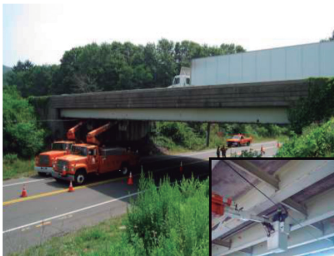
Figura 1. Ejemplo de instalación de sensores en prueba BWIM (Christenson y Motaref 2016).
