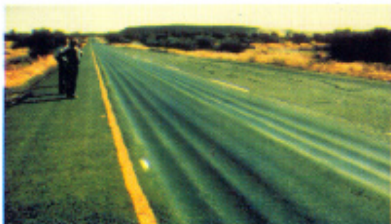
Figura No. 1: Deformación plástica.
