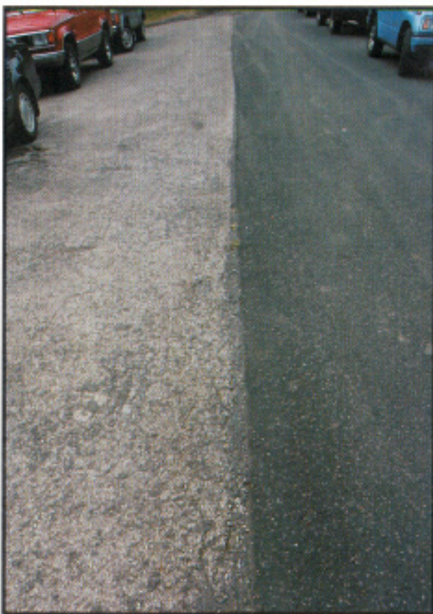
Otra vista donde puede observarse el caso de hormigón compactado con rodillo y del otro lado la carpeta asfáltica.
