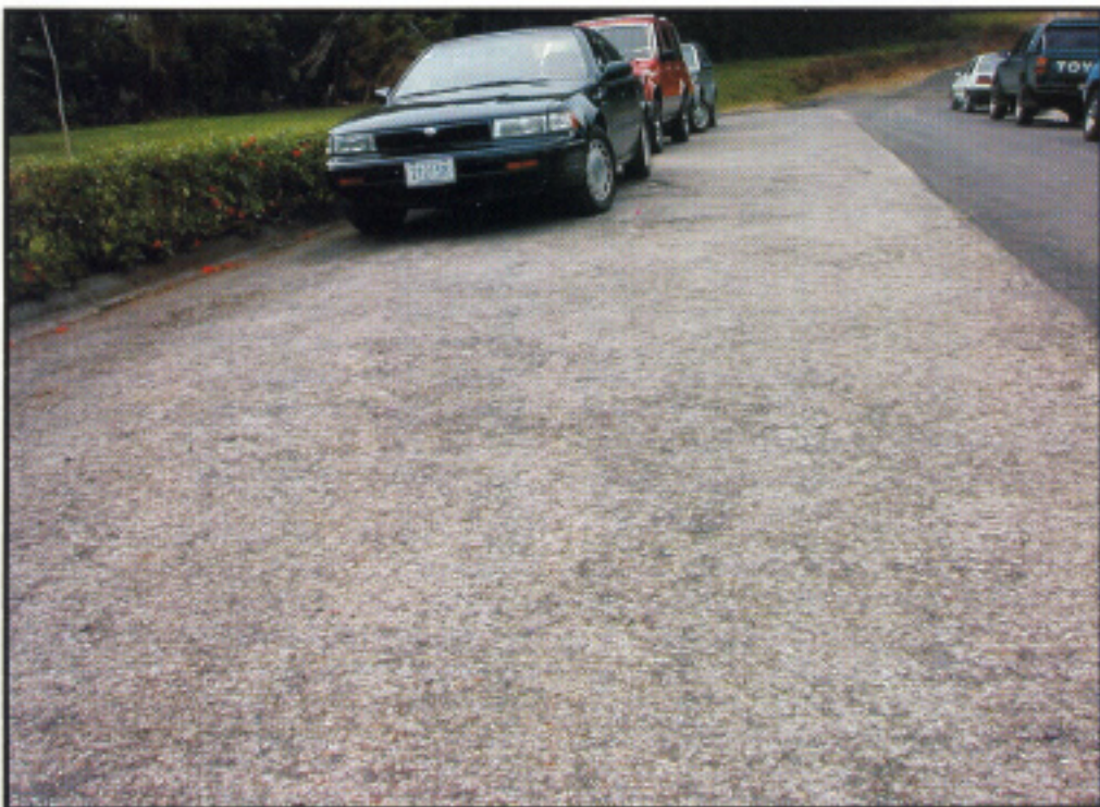
Primera experiencia de hormigón compactado con rodillo frente a las instalaciones del Laboratorio Nacional de Materiales y Modelos Estructurales, Ubicación: San Pedro de Montes de Oca, San José.
