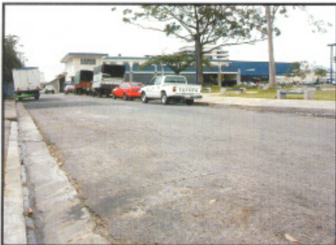
Pavimento de hormigón compactado con rodillo construido en cuadra urbana de tráfico pesado. Ubicación: Calle 4, entre avenidas 18 y 20, diagonal a la estación del Ferrocarril al Pacífico, Pacífico, San José.
