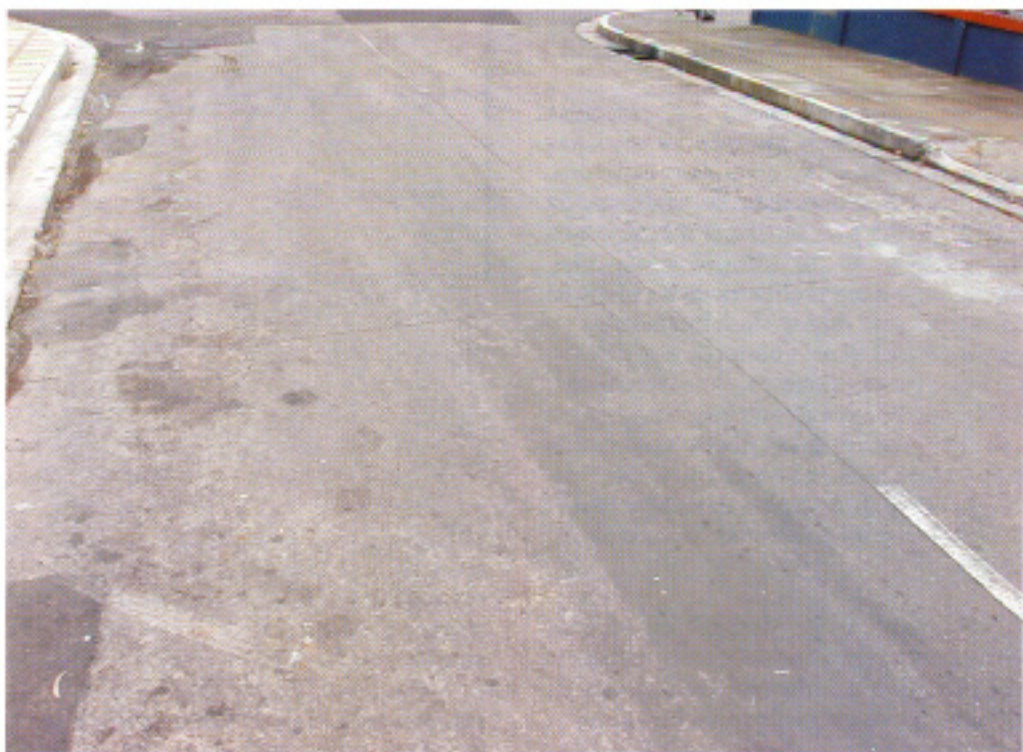
Tramo de prueba de hormigón compactado con rodillo en una calle urbana de San José.
