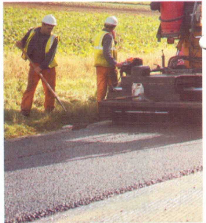
Colocación de capa de matriz de agregado grueso
