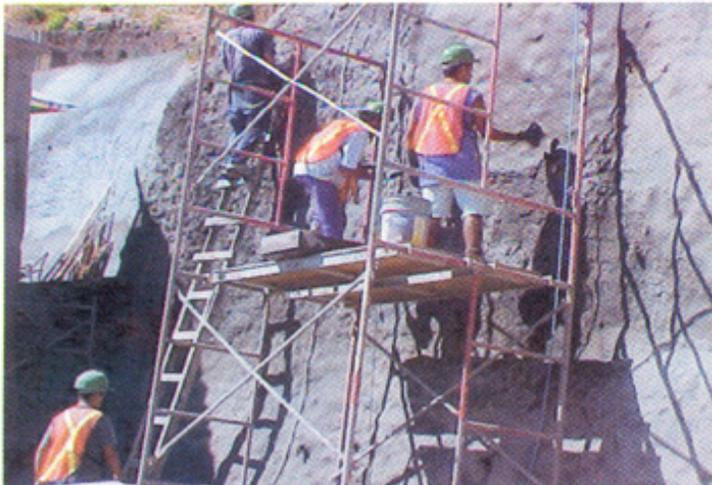
Foto 5. Construcción de Muro de Suelo Clavado (Soil Nailing) en Eco-Residencial Villa Real
