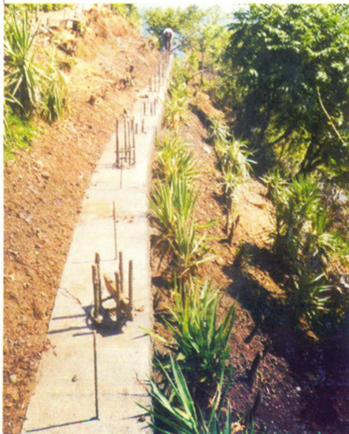
Foto 2. Pantalla de Pilotes para Estabilización de un Talud en Playa Herradura
