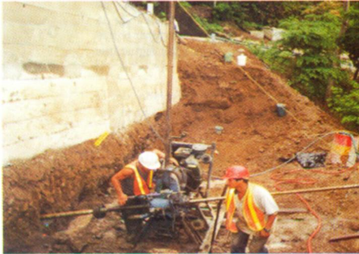
Foto 4. Construcción por Etapas de una Pantalla Anclada en Proyecto Papagayo
