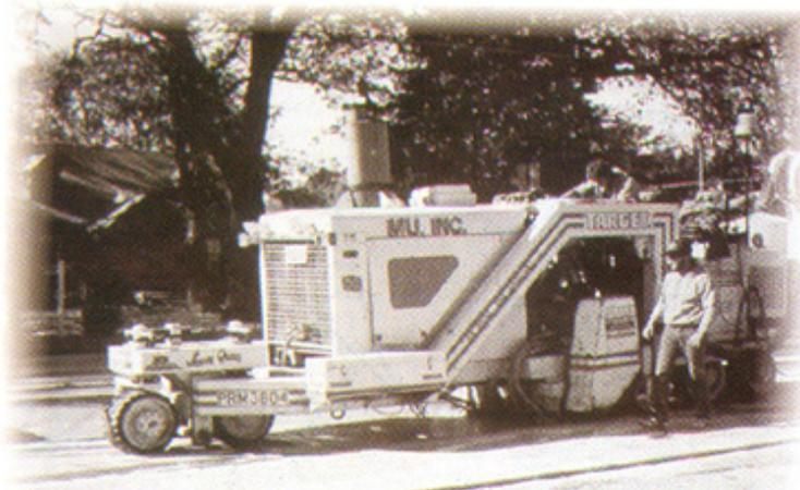
**Fotografía:** Esta máquina esmeriladora de diamante desgasta una capa delgada de concreto y elimina las fallas en el nivel de la superficie del pavimento
