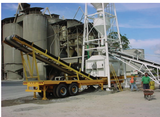
Fotografía 10. Mezcladora montada en carreta
