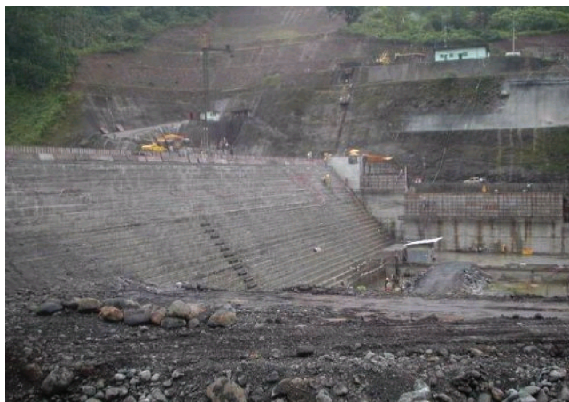
Fotografía 5. Presa de Peñas Blancas en construcción
