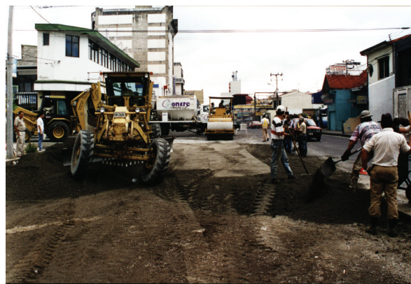
Fotografía 8. Pavimentación tramo Avenida Segunda
