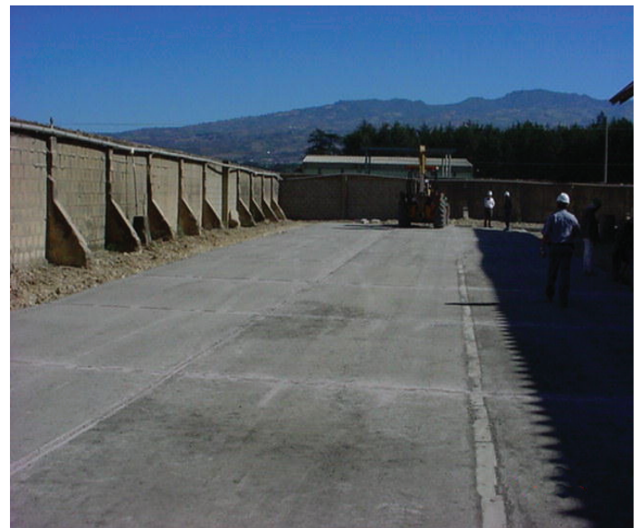
Fotografía 12. Patio de maniobras
