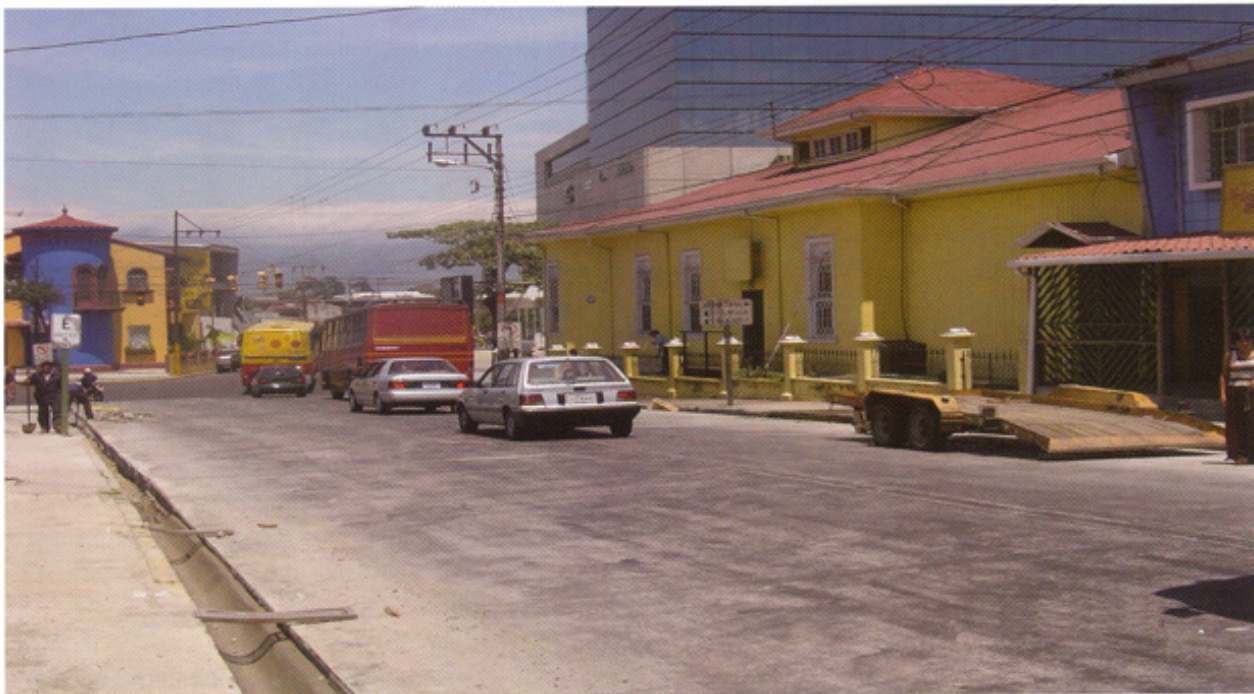
Calle 24, San José, en uso después de su reconstrucción
