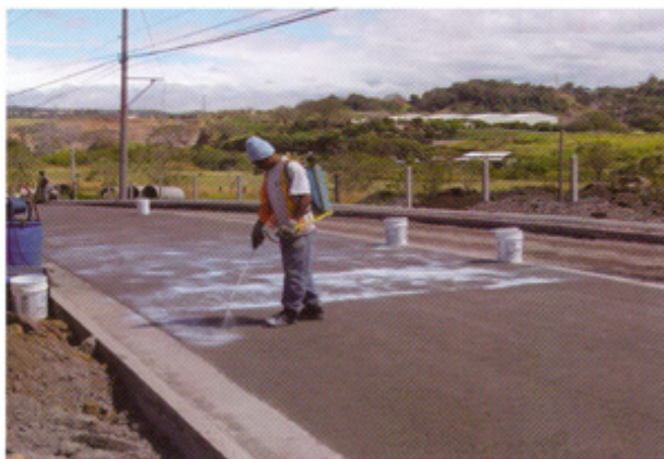
Curado con membrana
