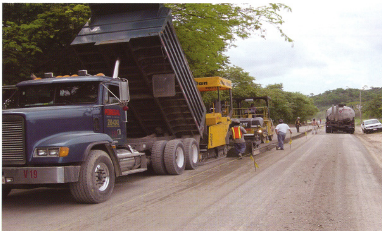
Parte del proceso de colocación del CCR en un tramo de la carretera que da acceso al puente de la Amistad sobre el río Tempisque
