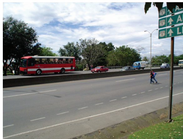
Ausencia de facilidades peatonales en la autopista General Cañas, una de las de más alto volumen de tránsito del país.
