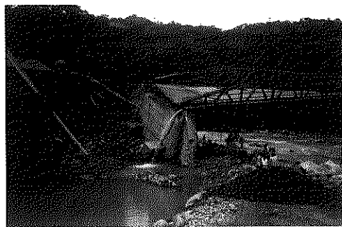
Foto 1. Falla de estribo del Puente Unete (Casanare)
