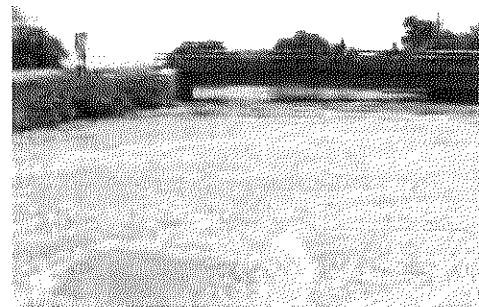
Foto 10. Problemas de contracción del flujo. Puente Mariano Ospina Pérez (Valle)
