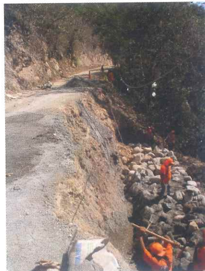
Figura 5 Obras de mitigación en desprendimiento de talud
