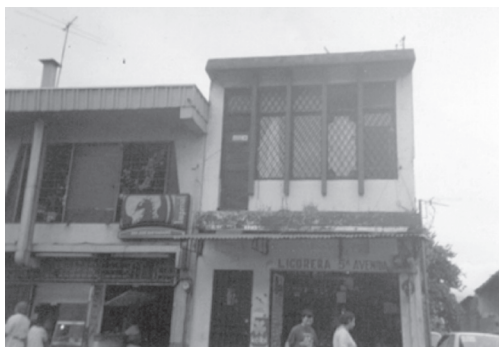
IMAGEN 1 LICORERA EN AVENIDA 5
