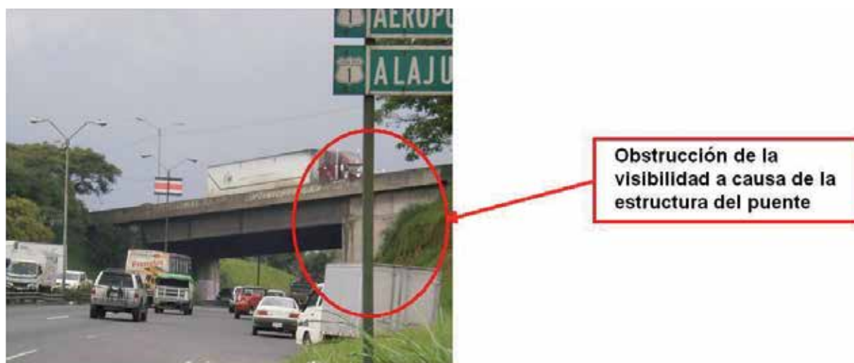
Figura 9. Obstrucción de la visibilidad a causa de la estructura de un puente
