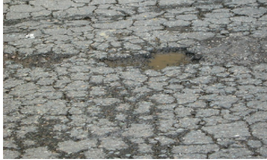
Figura 1a Fenómeno de bombeo; carga en la losa de acercamiento
