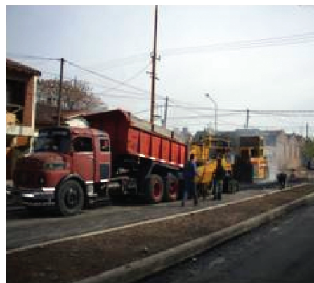
Fabricación y colocación de la mezcla densa en caliente con asfalto caucho
