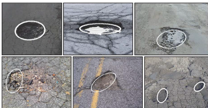
Figura 8. Detección de huecos a partir de algoritmos de detección de borde y umbralización (Koch et al., 2014)
