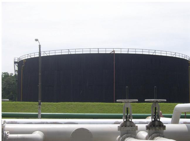
**Figura 2. Tanque vertical de fondo plano**
